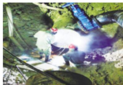
5月10日,昆仑山路DN800管道接水,停水时间为5月10日9点至次日5点,其20小时,因接水工程较大(3处接水点),为按时完成接水任务,保证及时供水,源通焊工班提前3天开始制作接水配件,减少接水的工程量。
