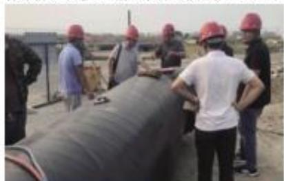
施工段，分别为：方洋河路跨中心河DN1000钢管沉管迁改264米，方洋河路与西安路交叉口DN1000钢管迁改72米，方洋河路西侧（创业大道）DN1000钢管迁改72米，计划工期为30日历天。主要内容为DN1000钢管的焊接和吊装工作。该段工程的难点为其中的128米过河管线，焊接完成后需要安装在桥梁侧面的支墩上。由于桥侧面上方是高压管线且桥面不适合吊车起吊，吊装工作难度较大。所以王斌跟总经理特别指出，一定要把安全放在第一位。经过专家、公司领导和技术人员的反复讨论、论证之后，最终决定在桥的两端各使用一台100吨吊车，在中间再架设一台200吨的吊车，最大限度的避开高压管线，并避免因管材过长而中间发生弯曲变形，确保本次吊装工作的成功。
